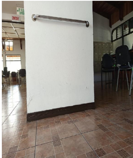
REPARACIÓN DE PAREDES DE LA ASOCIACIÓN
