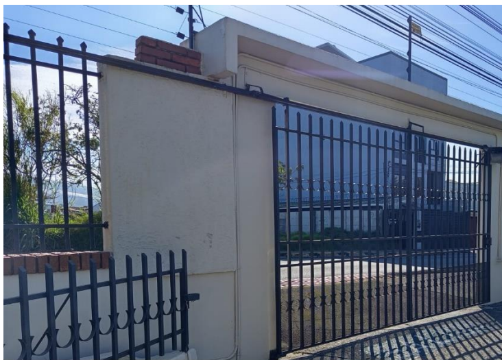
REPARACIÓN DE PORTONES ELECTRICOS Y MANUALES
