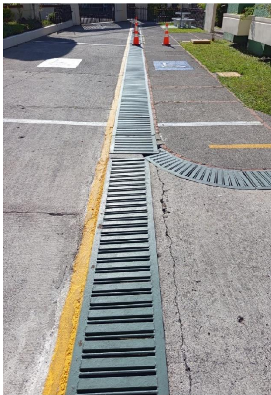
REPARACIÓN Y MANTENIMIENTO DE PARRILLAS
