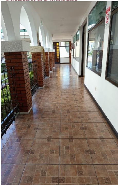
MANTENIMIENTO EN LOS PISOS CERAMICOS
