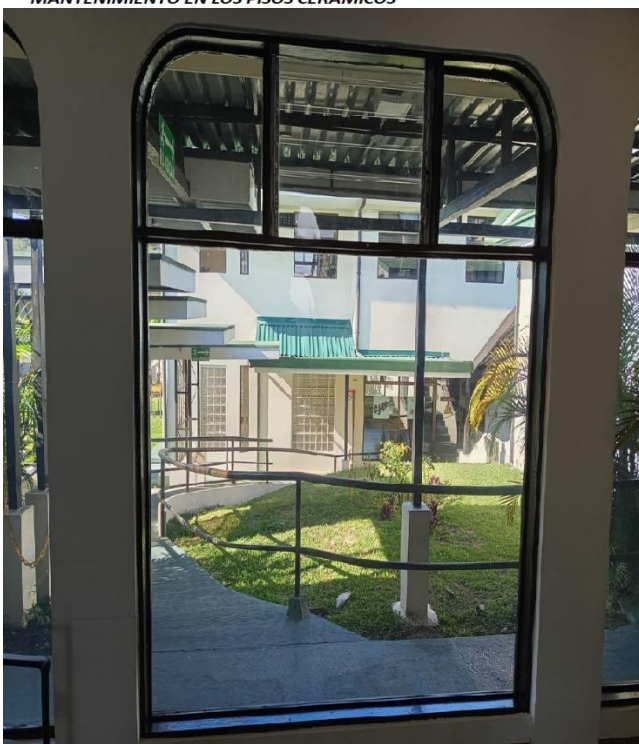
INSTALACIÓN Y REPARACIÓN DE VENILLAS DE ALUMINIO
