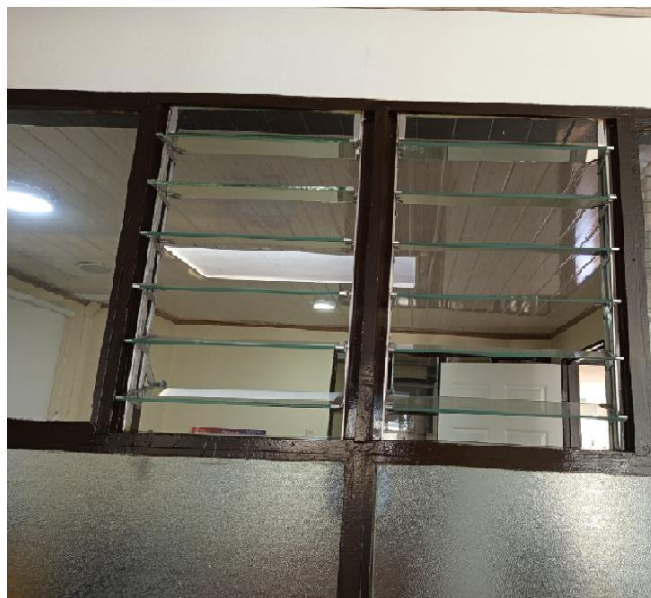
REPARACIÓN E INSTALACIÓN DE SEGUROS DE LAS CELOSIAS
