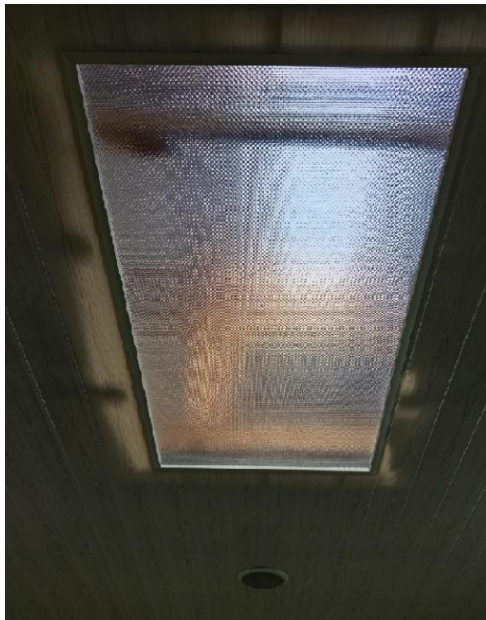
INSTALACIÓN Y MANTENIMIENTO DE CIELORRASOS
