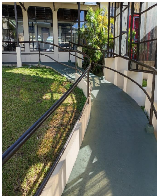
MANTENIMIENTO DE PASAMANOS Y BARRANDILLAS
