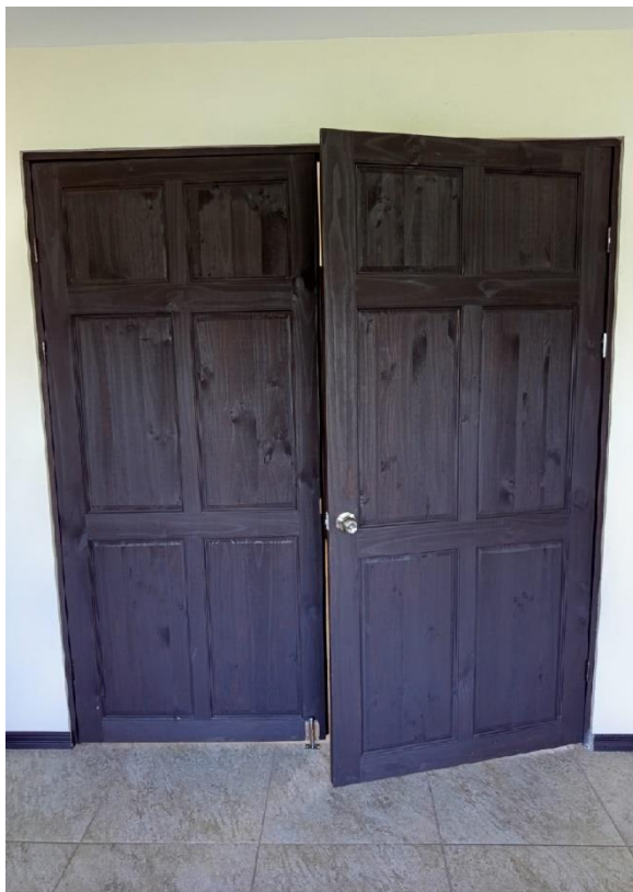
REPARACIÓN Y MANTENIMIENTO DE PUERTAS Y LLAVINES
